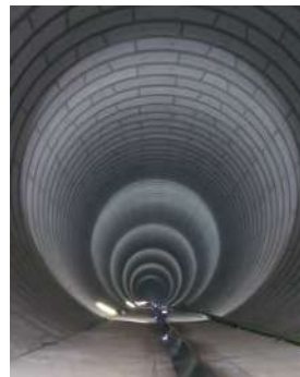
神田川・環状七号線地下調節池
