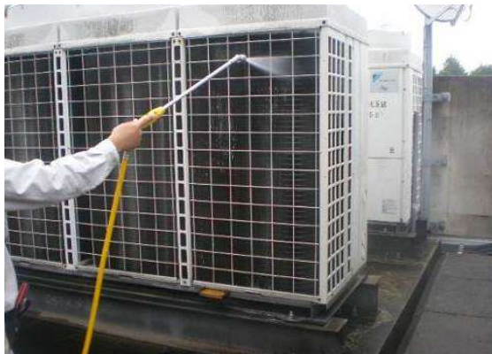
写真：空調室外機の清掃（フィンコイル）
